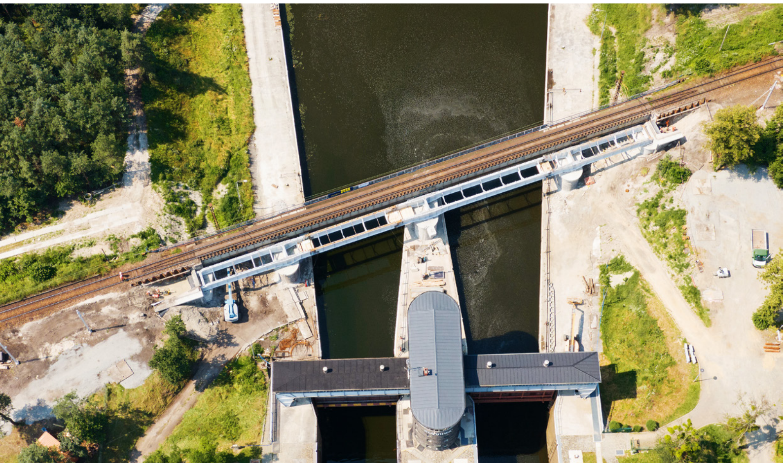
Most kolejowy nad Kanalem Gliwickim
