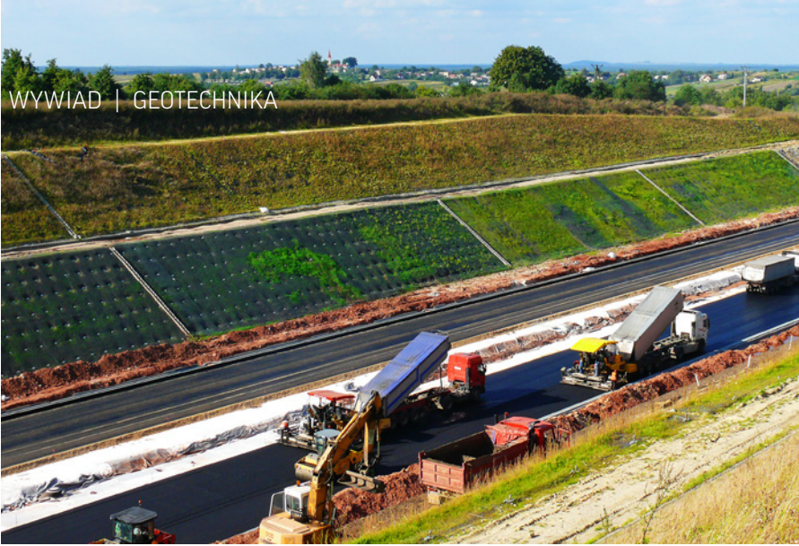
Budowa autostrady A1 Piekary Śląskie – Pyrzowice, zabezpieczenie skarp konstrukcjami gwoździowymi
