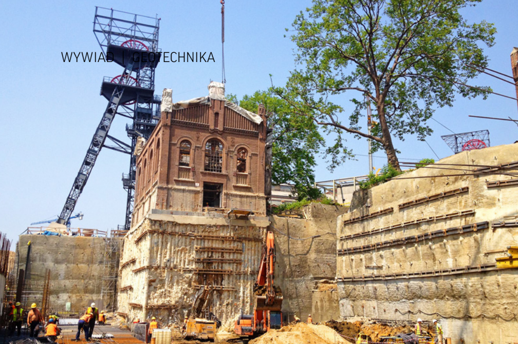
Budowa Muzeum Śląskiego w Katowicach, zabezpieczenie wykopów oraz podchwycenie i wzmocnienie budynków
