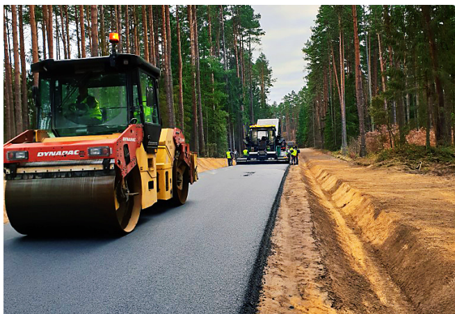
Zastosowanie asfaltu WMA na drodze powiatowej, temperatura powietrza 0 °C
