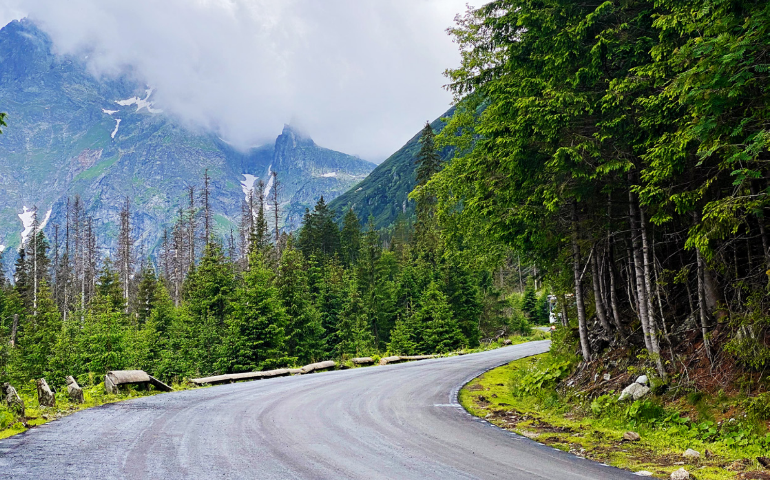
Droga do Morskiego Oka, nawierzchnia w technologii WMA
