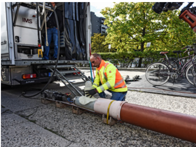
Pokaz pracy robota do napraw bezwykopowych firmy IMS-Robotics GmbH
