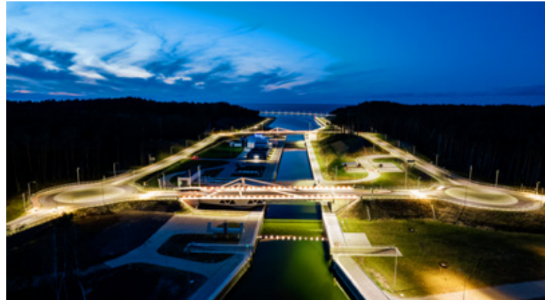
Kanał żeglowny przez Mierzęję Wiślaną, fot. NDI/Besix
