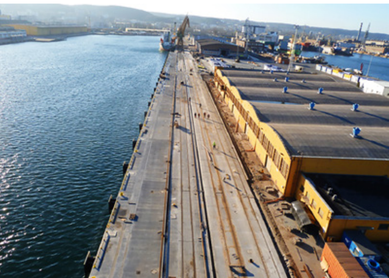
Nabrzeże Rumuńskie po wykonaniu przebudowy
