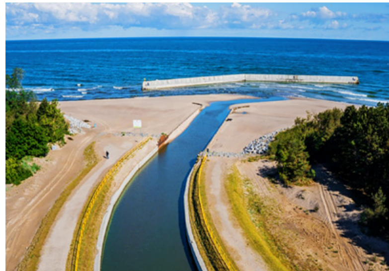
Po wykonaniu konstrukcji ochrony brzegu morskiego
