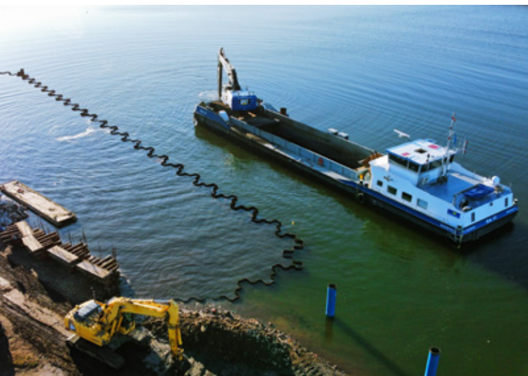
Wykonane posadowienie nabrzeża – ścianka szczelna wspornikowa o profilu GU-13N, zamki Omega 18 i trwające prace czerpalne
