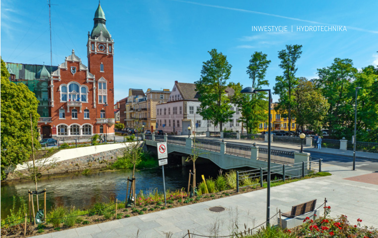
Przebudowa bulwarów Słupia w Słupsku
