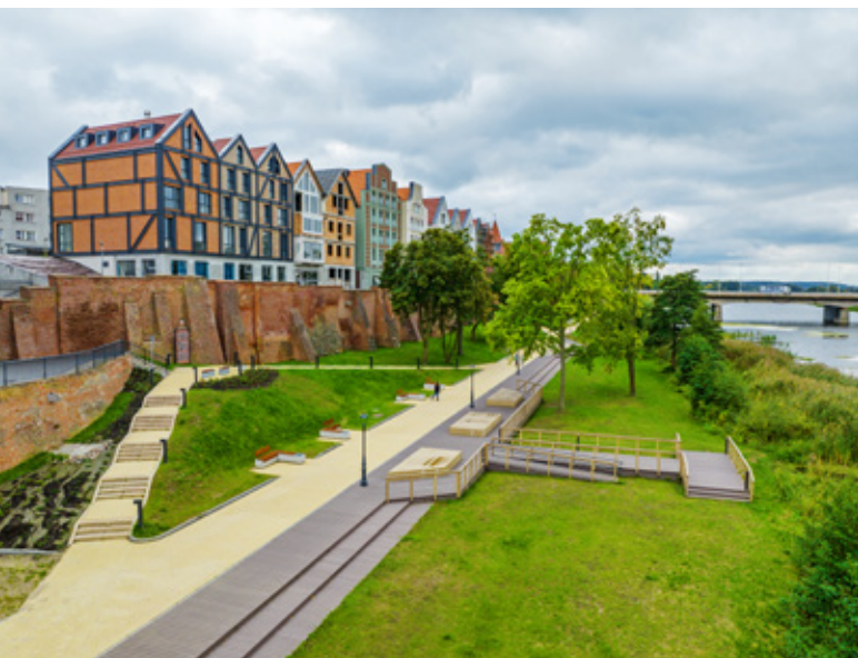
Widok na przebudowane bulwary
