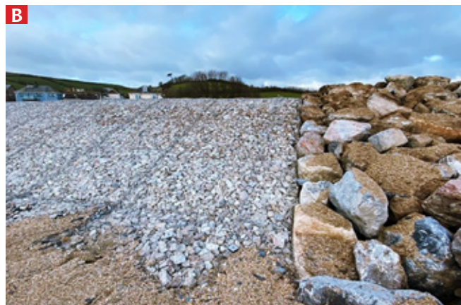
Ryc. 3. Zabudowa Tecco Cell: a) zabudowa w 2021 r., źródło: Landmarc, https://landmarc.co.uk/ , b) zakończona zabudowa zabezpieczenia brzegu w 2021 r., źródło Landmarc, https://landmarc.co.uk/
