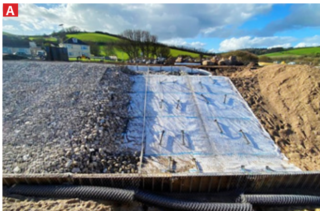
Ryc. 3. Zabudowa Tecco Cell: a) zabudowa w 2021 r., źródło: Landmarc, https://landmarc.co.uk/ , b) zakończona zabudowa zabezpieczenia brzegu w 2021 r., źródło Landmarc, https://landmarc.co.uk/
