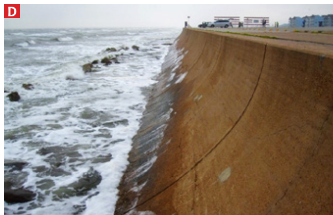
Ryc. 1. Różne rodzaje zabezpieczenia wybrzeża: a) ochrona skalna, źródło: Jonathan Wilkins, www.geograph.co.uk , b) bloki prefabrykatu betonowego, źródło: Coastalwiki, www.coastalwiki.org , c) bloki lub kamienie w oczkach siatki stalowej, źródło: Geobrugg AG, www.geobrugg.com , d) zakrzywiony betonowy falochron, źródło: Engineering Civil, https://engineeringcivil.org
