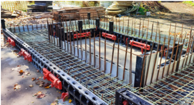
Przygotowanie modułu stropowego ze zbrojeniem kompozytowym
