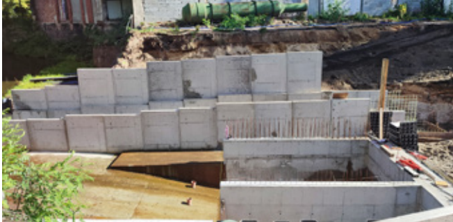
MEW Papiernia – modułowy blok elektrowni z przepławką dla ryb
