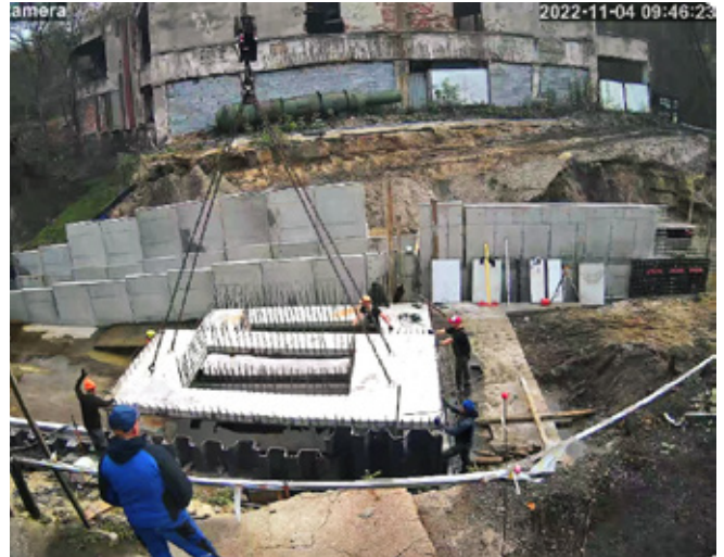
Układanie modułu stropowego w bloku MEW
