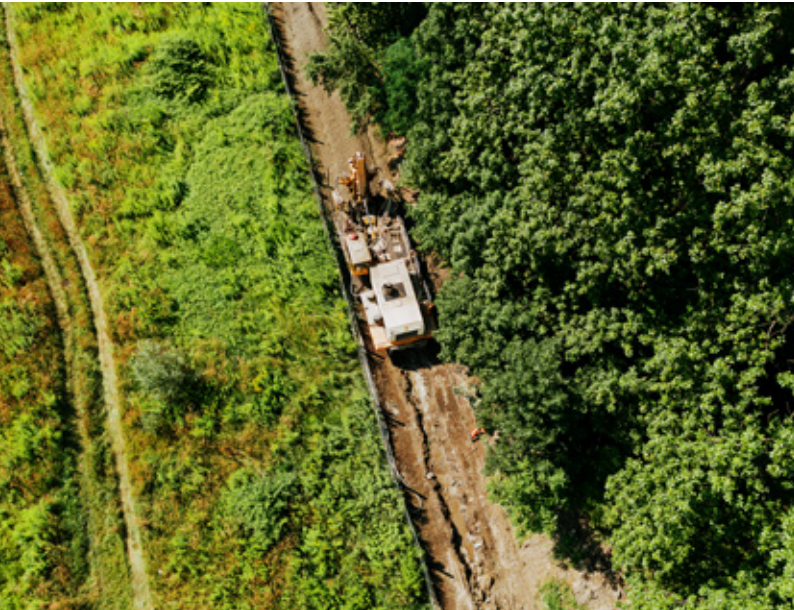
Realizacja pionowej przesłony przeciwfiltracyjnej, staw Kalina, technologia TRENCHMIX, archiwum Soletanche Polska
