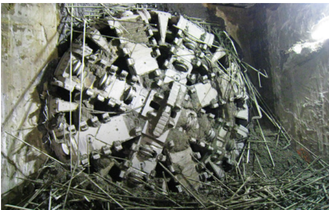
Ryc. 7. Widok głowicy skrawającej tarczy Maria po wydrążeniu tunelu szlakowego i przejściu przez ścianę szczelinową stacji zbrojoną prętami z włókna szklanego [7]
