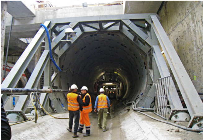
Ryc. 8. Konstrukcja опорowa i zmontowany fragment obudowy tunelu w szybie startowym tarczy [7]
