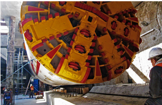
Ryc. 6. Widok głowicy skrawającej tarczy Maria w momencie opuszczania do szybu startowego [7]
