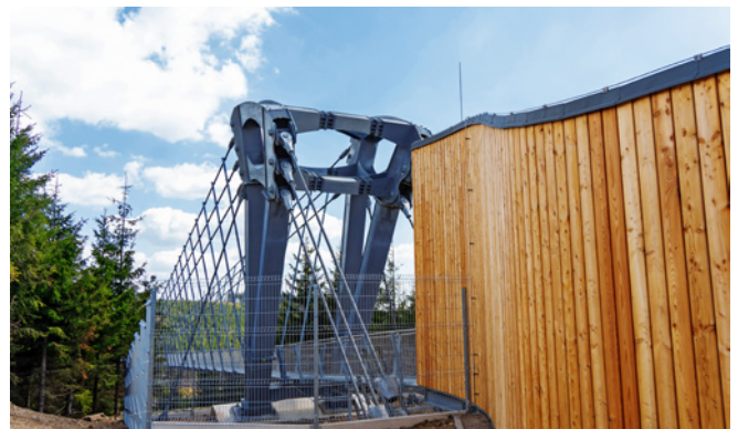
Ryc. 2. Widok pylonu z tylnymi linami kontruującymi
