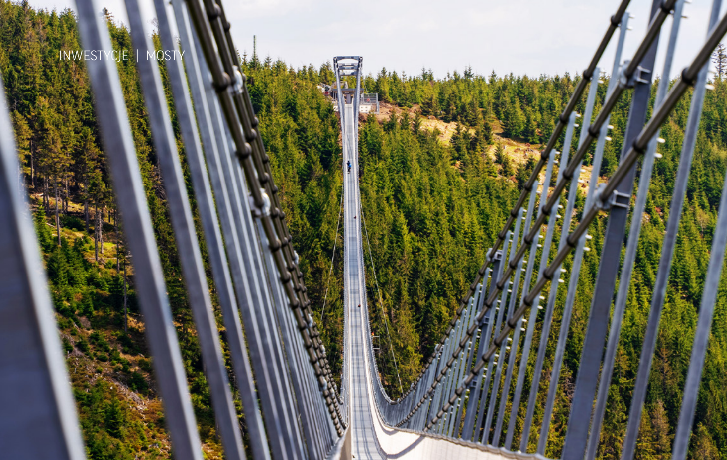
Ryc. 4. Widok na gotowy obiekt
