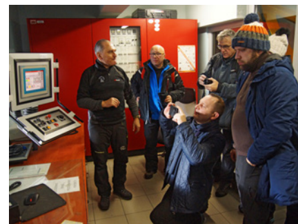
Zwiedzanie maszynowni stacji przesiadkowej kolei linowej na Kasprowy Wierch
