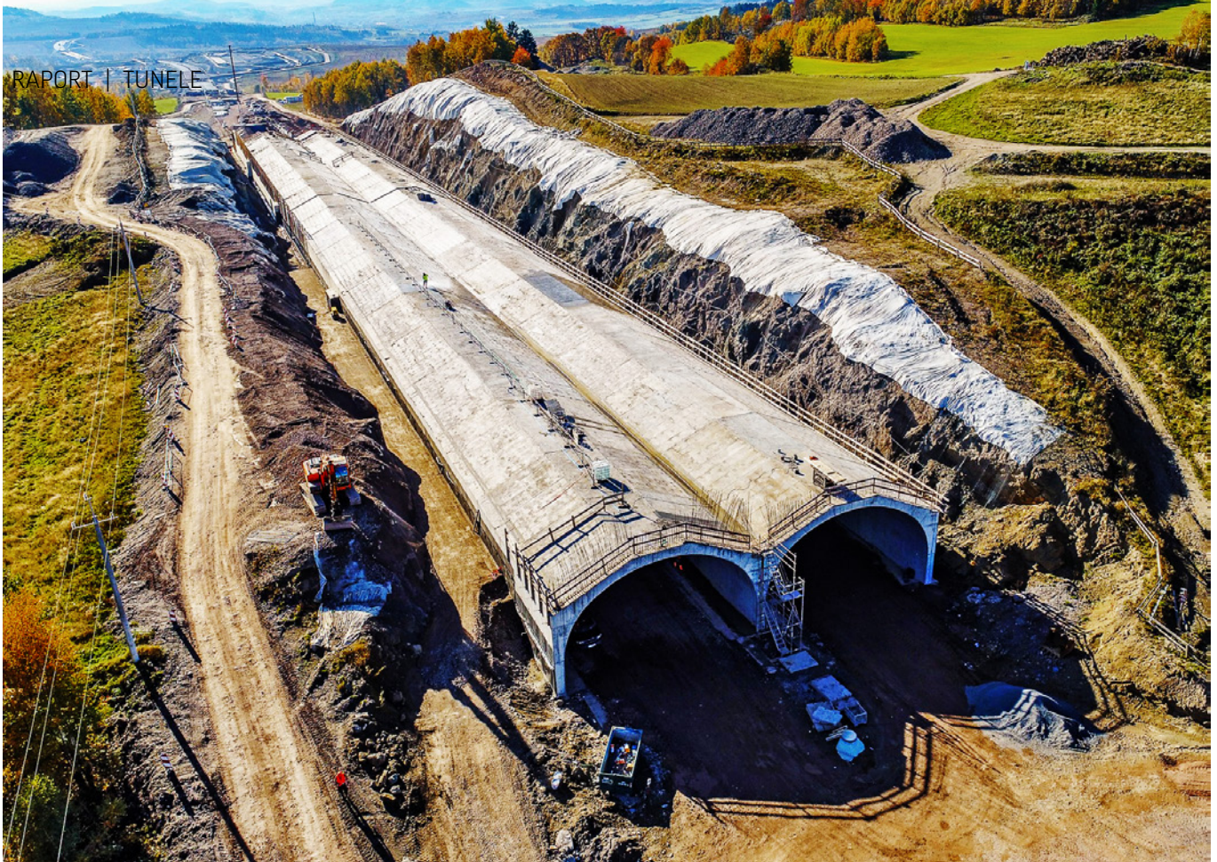
Tunel w ciągu drogi ekspresowej S3 Bolków – Kamienna Góra (TS-32), fot. GDDKiA
