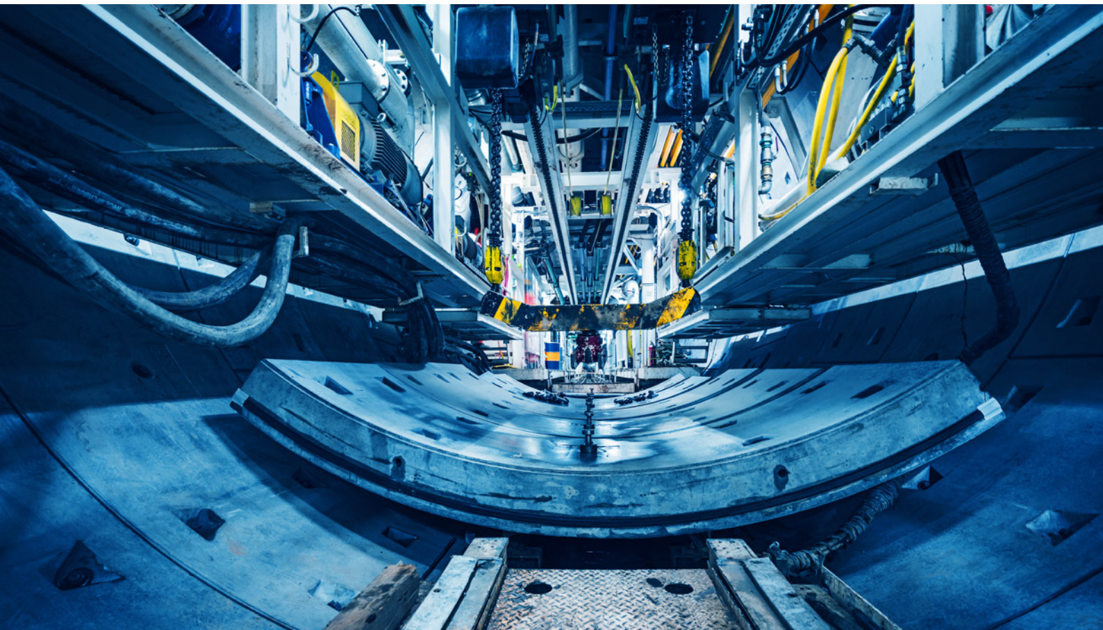
Proces układania tubingów podczas obudowy tunelu, fot. gjp311, Adobe Stock
