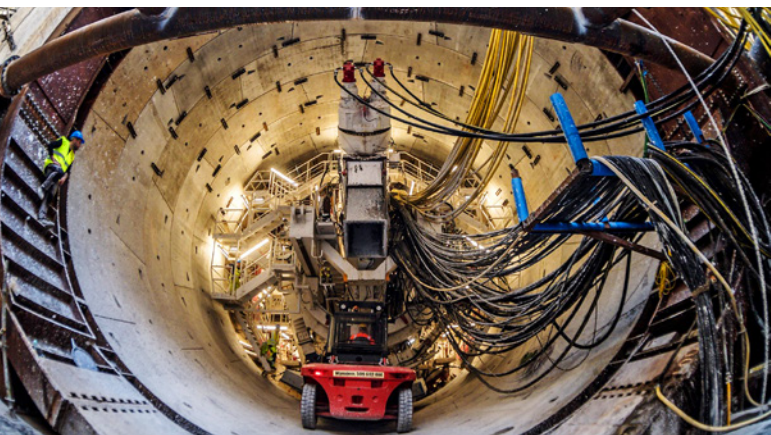
Budowa tunelu średnicowego w Łodzi, fot. PKP PLK S.A.
