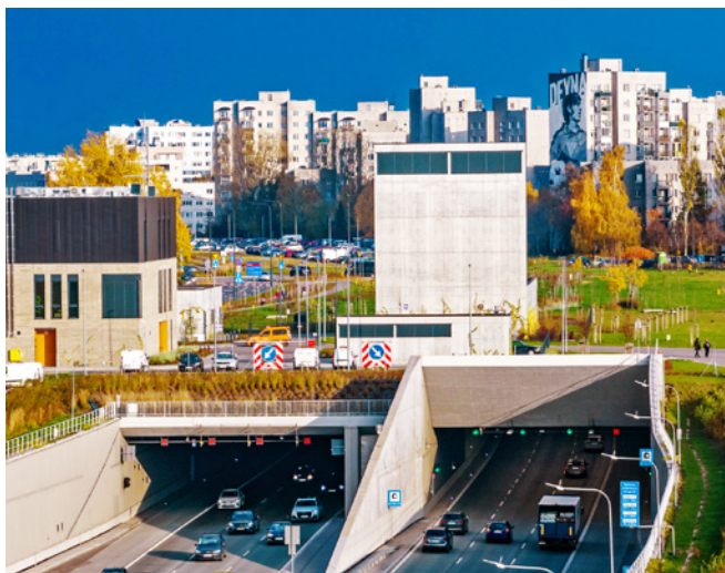
Tunel na Południowej Obwodnicy Warszawy, fot. GDDKiA
