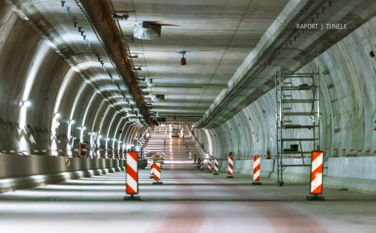
Tunel pod Świną w ciągu DK93, fot. PORR SA
