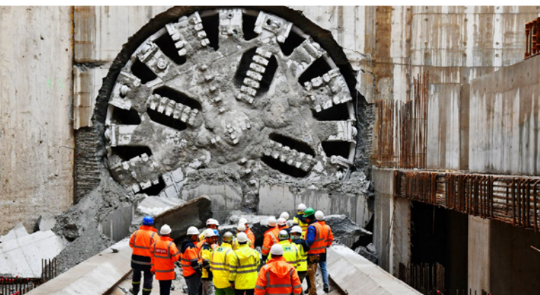
Budowa tunelu średnicowego w Łodzi, fot. R. Wilgusiak, PKP PLK S.A.
