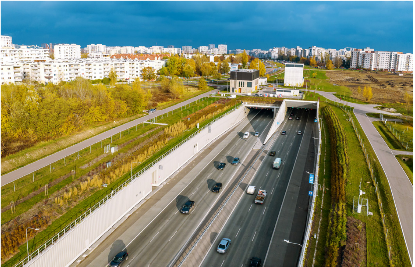
W 2021 r. został oddany tunel w ciągu S2 Południowej Obwodnicy Warszawy o długości 2335 m. Obiekt naszpikowany jest nowoczesną technologią i wyposażony w 13 systemów bezpieczeństwa, fot. K. Nalewajko, GDDKiA
