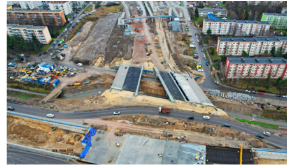
Budowa tunelu na ul. Opolskiej
