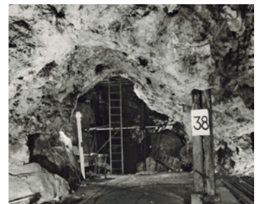
Ryc. 5. Podpora odspojonych skał wapiennych w ociosie komory C, fot. z archiwum AGH
