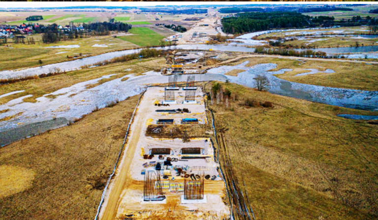
Budowa drogi ekspresowej S61 Ostrow Mazowiecka – Szczuczyn, odcinek od węzła Łomża Zachód (z węzłem) do węzła Kolno (bez węzła), fot. GDDKiA
