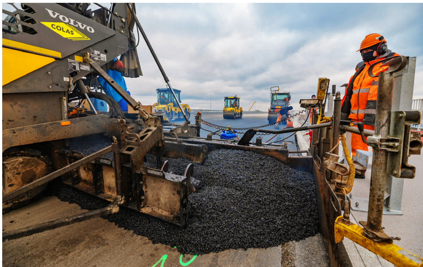
Wykonywanie nawierzchni asfaltowej podczas budowy S2 POW, fot. K. Nalewajko, GDDKiA
