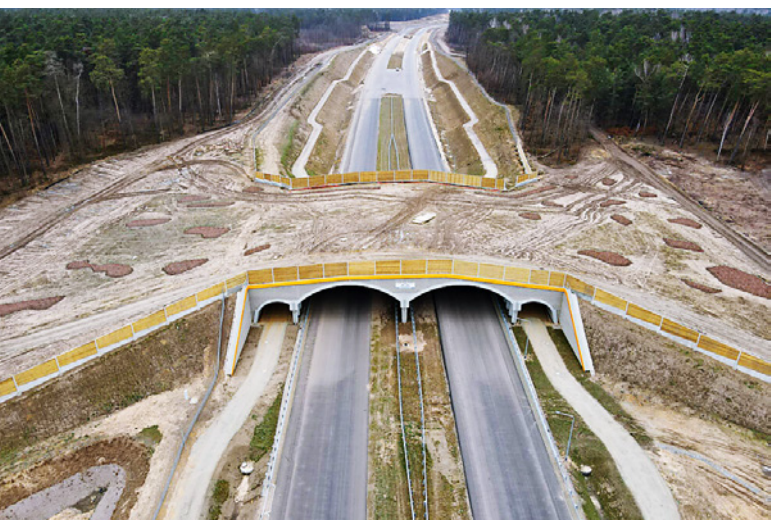
Budowa zachodniej obwodnicy Łodzi w ciągu S14, fot. GDDKiA
