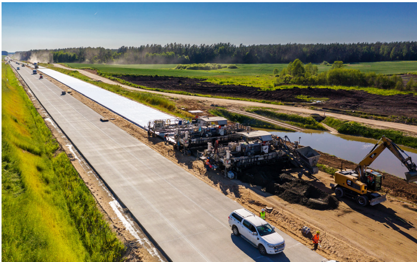
Wykonywanie nawierzchni betonowej podczas budowy S61 Wysokie – Raczek, fot. K. Nalewajko, GDDKiA
