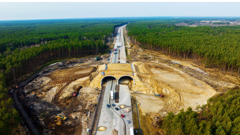
Budowa autostrady A18 Olszyna – Golnice, fot. GDDKiA
