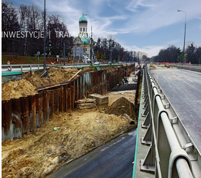
Odcinek wykonanych stalowych ścianek szczelnych
