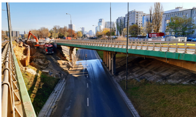
Końcowy zakres docelowego wykopu w ściankach szczelnych
