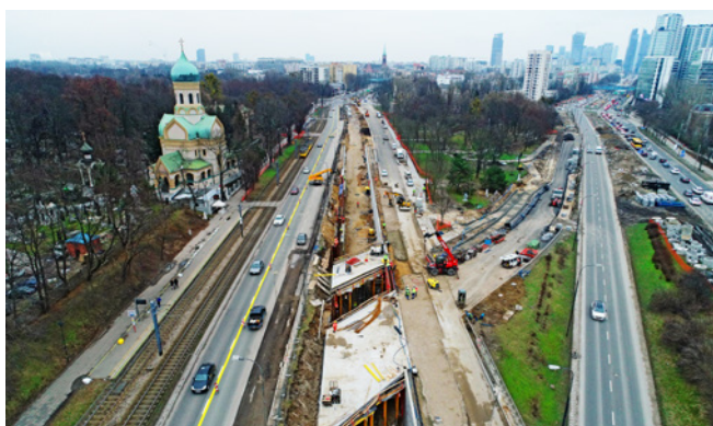
Prace konstrukcyjne przy wiadukcie drogowym oraz kładce nr 1
