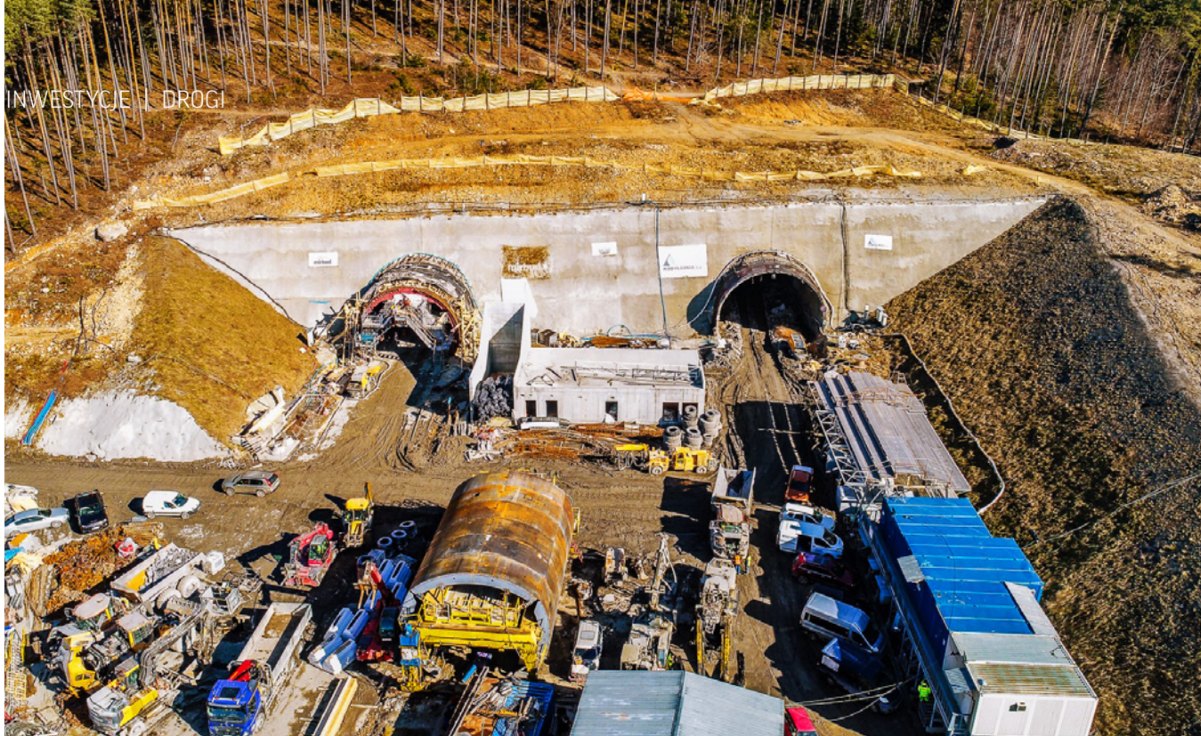
Portal tunelu TD-1 przez masyw Barania Góra
