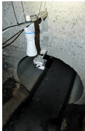
Pomiary napętnienia i prędkości przepływu ścieków
