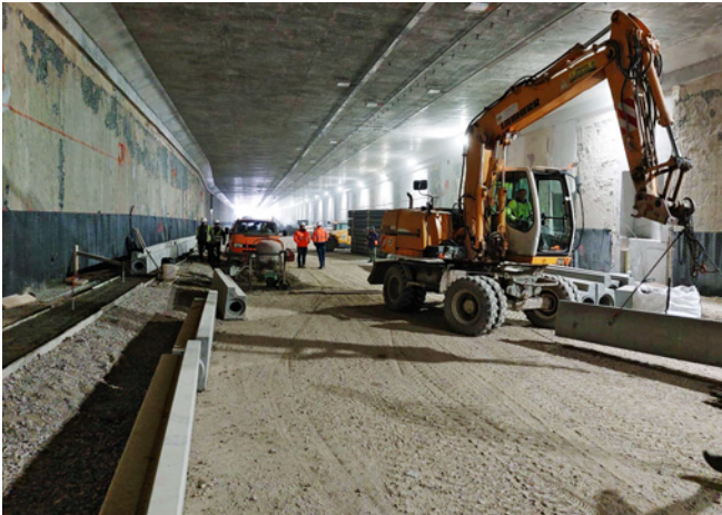
Budowa tunelu na Północnej Obwodnicy Krakowa, fot. GDDKiA
