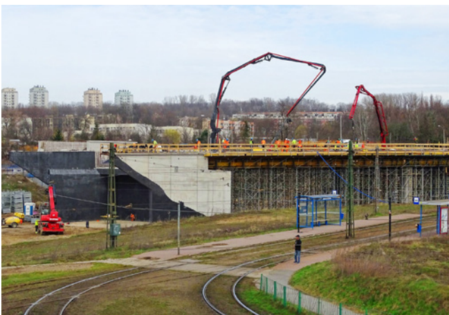
Budowa S52 w Krakowie, fot. GDDKiA
