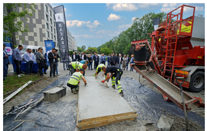
Pokaz betonowania nawierzchni przy zastosowaniu betonu szybkosprawnego
