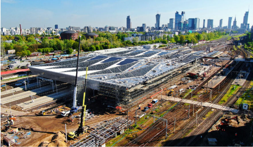
Przebudowa stacji Warszawa Zachodnia, fot. PLK S.A.
