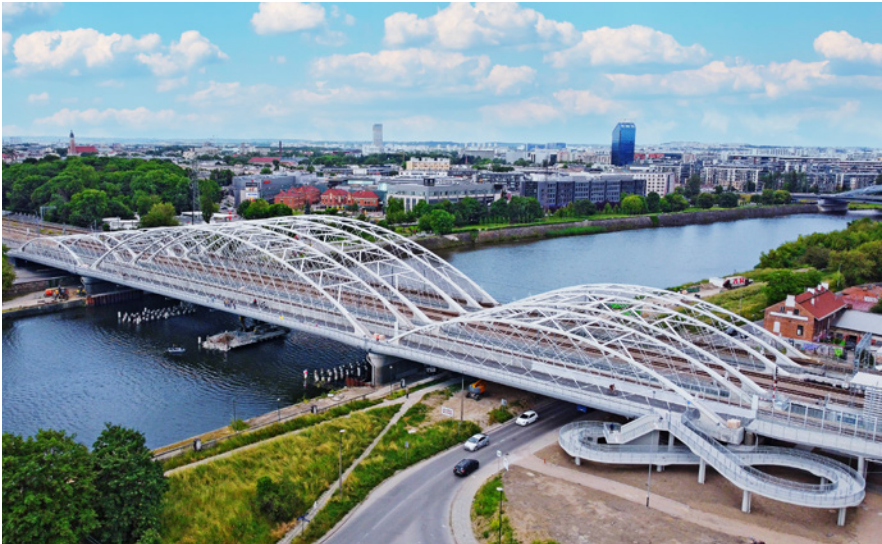
Nowe wiadukty kolejowe nad Wisłą w Krakowie, linia E30, fot. P. Hamarnik, PLK S.A.
