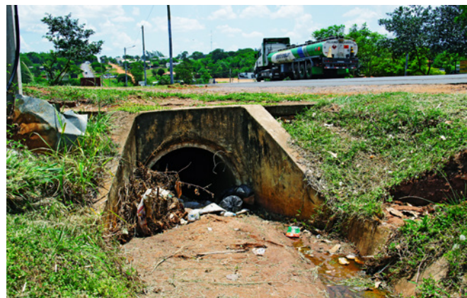
Ryc. 10. Negatywny przykład utrzymania przepustu drogowego (przykład z Ameryki Południowej), fot. A. Wysokowski
