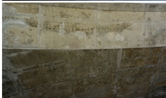
Ryc. 12. Przykład powierzchni betonowej przejścia dla zwierząt przygotowanej do aplikacji dodatkowych środków zabezpieczających w trakcie budowy, fot. A. Wysokowski
