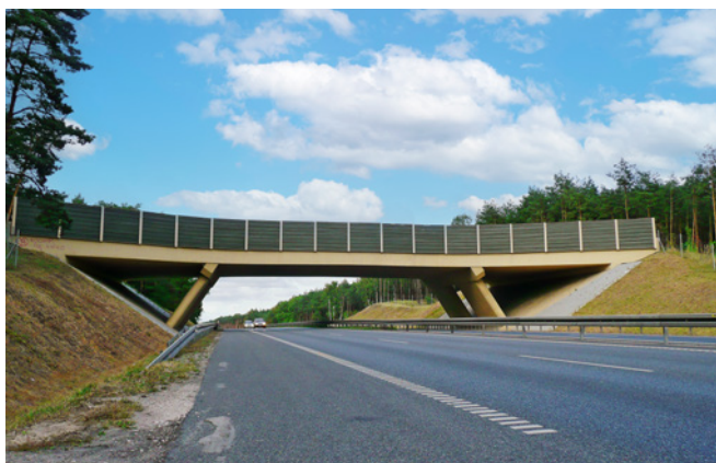
Ryc. 2. Przykład żelbetowej, masywnej konstrukcji ramowej przejścia dla zwierząt, fot. A. Wysokowski
