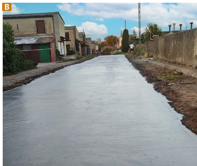
Ryc. 2. Przygotowanie podłoża pod podbudowę z pianobetonu (a) oraz wykonywanie warstwy podbudowy z pianobetonu (b)
