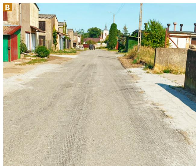
Ryc. 3. Wykonywanie powierzchniowego utrwalenia (a) i nawierzchnia odcinka testowego po siedmiu dniach od oddania odcinka do eksploatacji (b)
