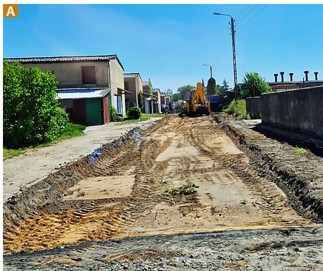
Ryc. 2. Przygotowanie podłoża pod podbudowę z pianobetonu (a) oraz wykonywanie warstwy podbudowy z pianobetonu (b)
