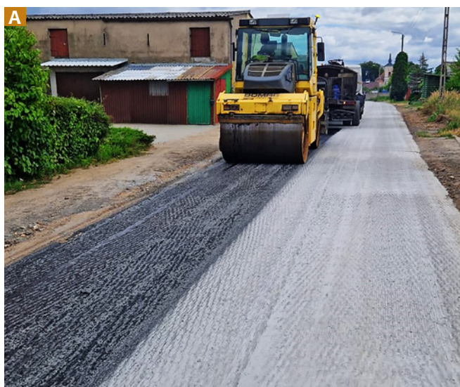
Ryc. 3. Wykonywanie powierzchniowego utrwalenia (a) i nawierzchnia odcinka testowego po siedmiu dniach od oddania odcinka do eksploatacji (b)
