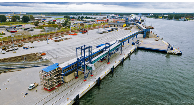
Terminal promowy w Świnoujściu, fot. ZMPSIŚ SA
