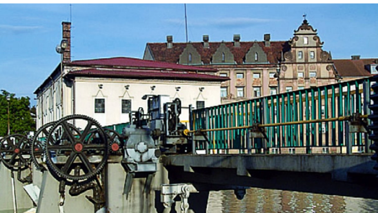
Elektrownia Wodna Gubin, fot. PGE Energia Odnawialna SA
