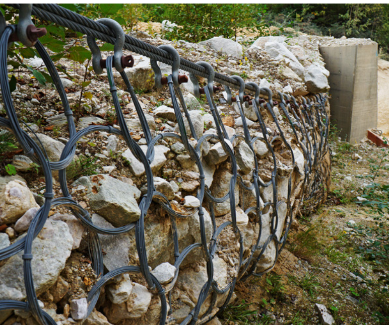
Ryc. 4. Wypełniona elastyczna bariera przeciwrumowiskowa
