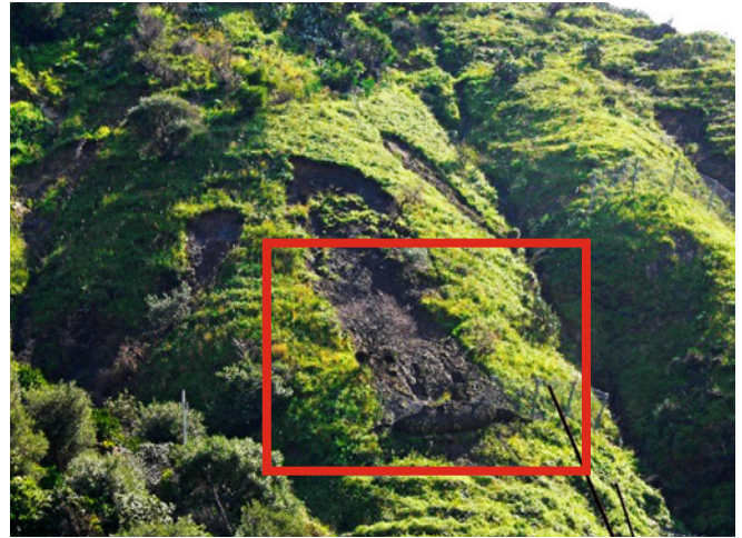
Ryc. 3. Częściowo wypełniona bariera przeciw płytkim osuwiskom / splywom gruzowym stokowym SL-150 (czerwony prostokąt) ze strefą początkową powyżej konstrukcji
