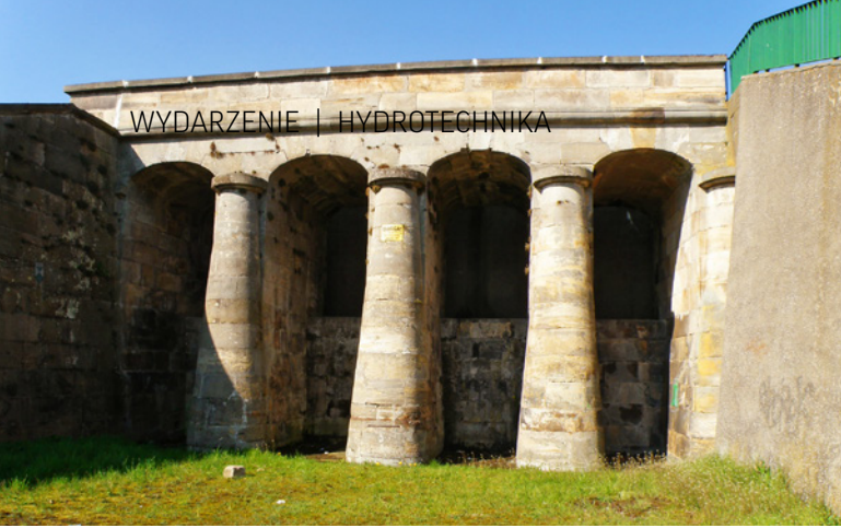
Ryc. 3. Zapora Brody Iłżeckie z 1964 r. na rzece Kamiennej z zachowanym kamiennym przelewem starej zapory z 1840 r., wkomponowanym w skarpe odpowietrzną obecnej zapory, fot. P. Kuźniar
