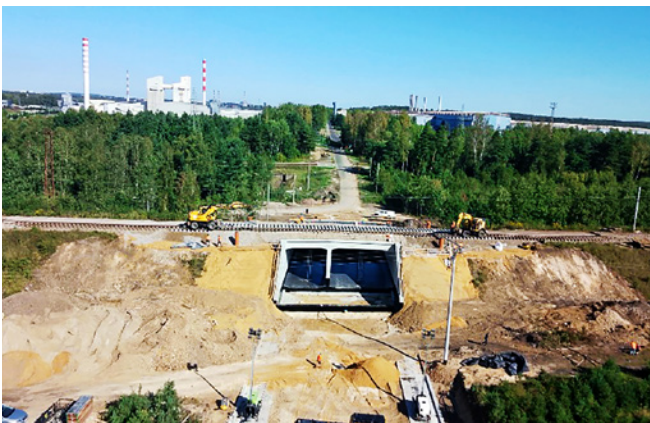
Budowa nawierzchni torowej
