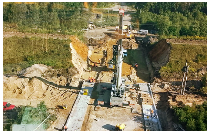
Montaż prefabrykatów toru ślizgowego
