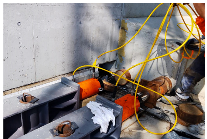
Zestaw siłowników hydraulicznych 2 x 100 t
