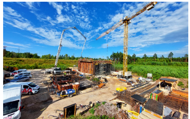
Betonowanie ustroju nośnego ramy
