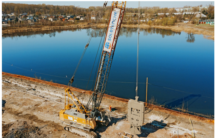
Realizacja pionowej przesłony przeciwfiltracyjnej w technologii przesłony kopanej, mającej na celu zatrzymanie przenikania chemikaliów z hałdy do stawu Kalina w Świętochłowicach
