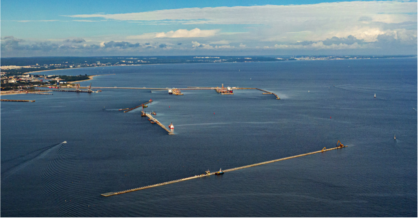
Modernizacja układu falochronów ostonowych w Porcie Północnym w Gdańsku, widok w kierunku zachodnim, 2018–2021, zamawiający: Urząd Morski w Gdyni, fot. J. Maj
