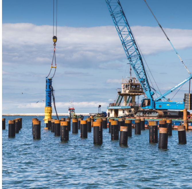
Terminal LNG, Świnoujście
